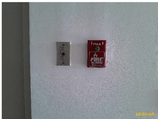
สัญญาณเพลิงไหม้ด้วยมือ
