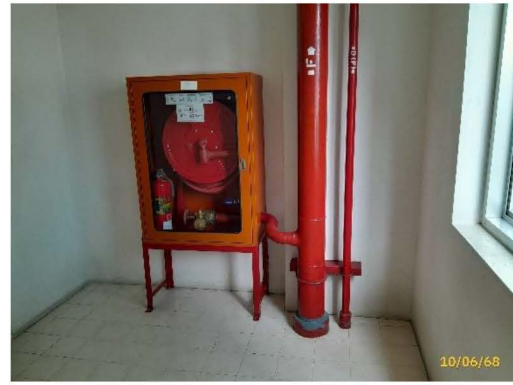
ตู้เก็บสายน้ำดับเพลิง พร้อมอุปกรณ์
